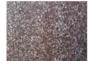
Lastryko z wypełniaczem skał marmurowych, ul. Puławska 24 a
