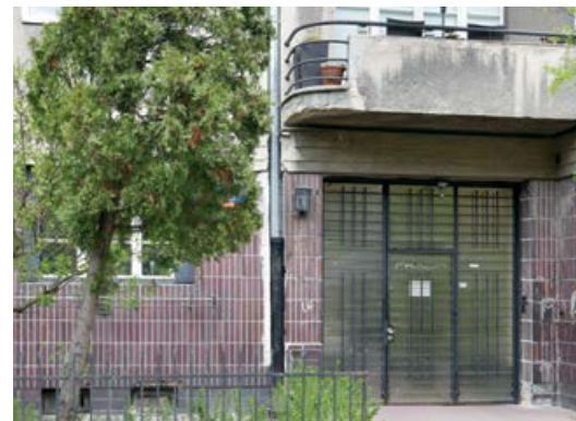
Ogrodzenie, balustrady balkonowe, brama, ul. Narbutta 8
