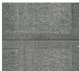
Tynk kamieniarski, ul. Skolimowska 3
