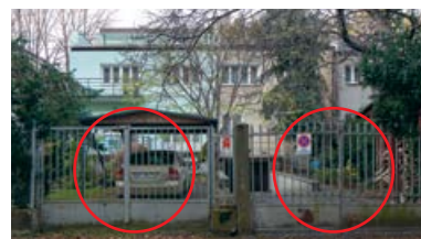
Niespójne, indywidualne rozwiązania remontowe, ul. Madalińskiego/ul. Karłowicza
