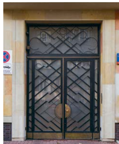
Brama po remoncie, ul. Narbutta 22
