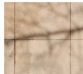
Tynk gładki imitujący okładzinę kamienną, ul. Madalińskiego 71
